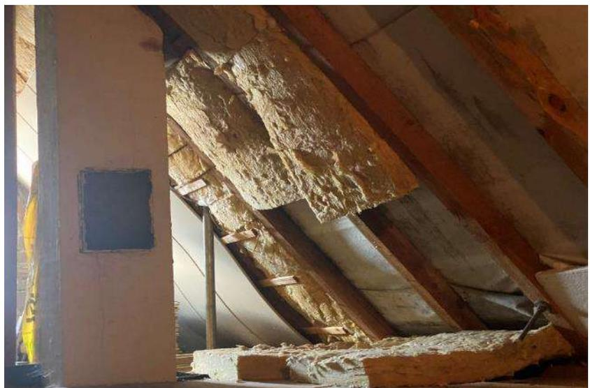
**Abb. 5:** Foto des SV; z.T. Dachdämmung schadhaft (Spitzboden)
