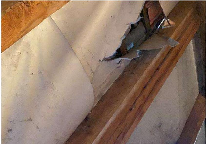
**Abb. 6:** Foto des SV; z.T. Unterspannbahn schadhaft (Spitzboden)
